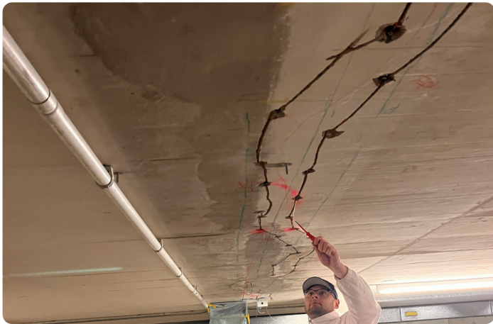
Verdrahten der Stabanoden
