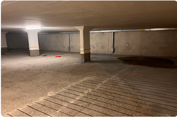
Installation der Primär- und Sekundäranoden für den kathodischen Korrosionsschutz
