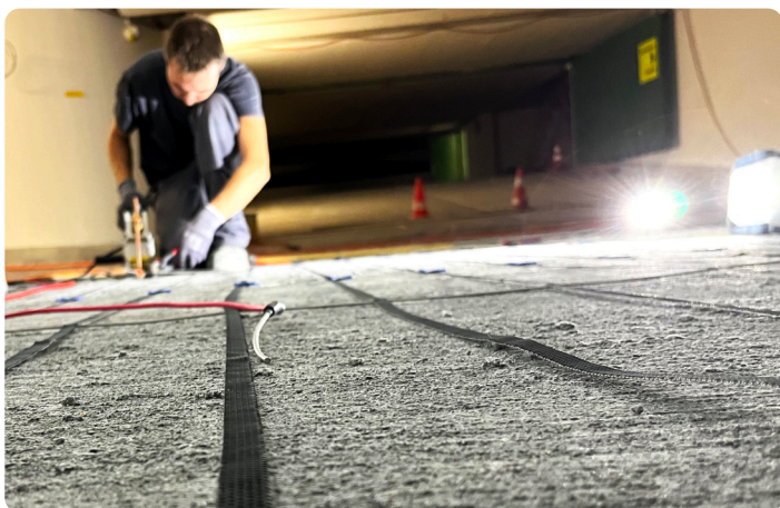
Installation der Primär- und Sekundäranoden für den kathodischen Korrosionsschutz
