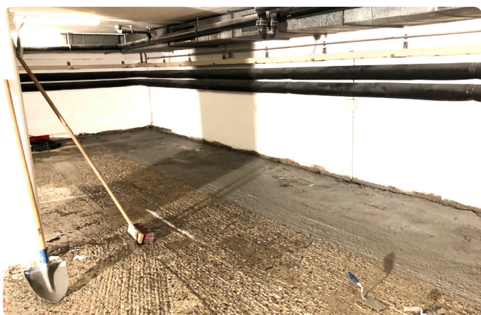
Einbringen des neuen Unterlagsbodens
