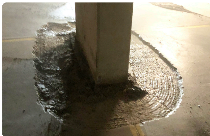
Beginn der Fräsarbeiten rund um die Stützen
