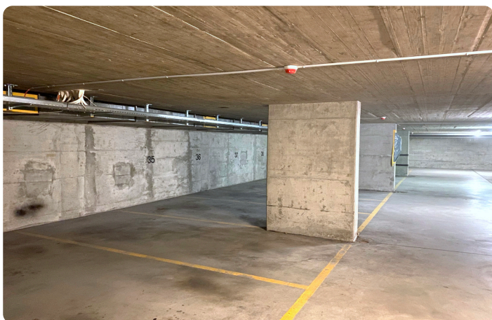
Zustand der Einstellhalle vor der Instandsetzung
