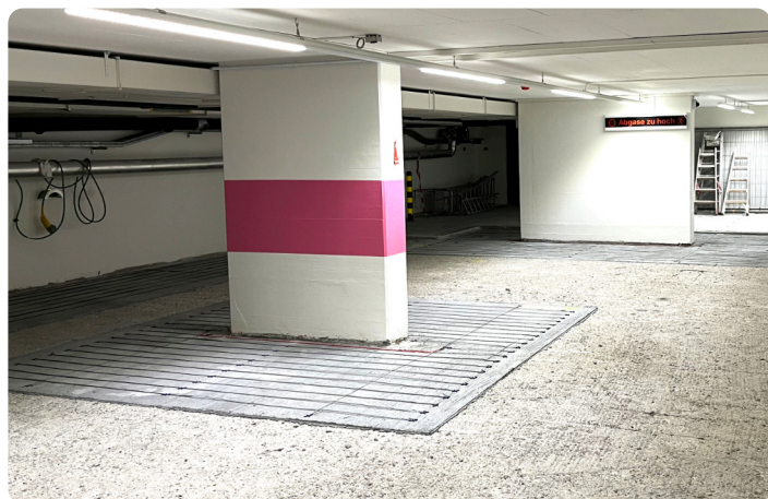
Verlegte Anodenbänder im Stützenbereich und entlang der Wände
