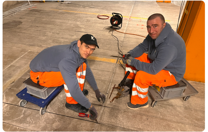
Punktschweissen der Primär- und Sekundäranoden für eine dauerhafte elektrische Verbindung
