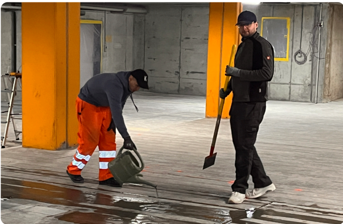
Vergiessen der Schlitze mit Flüssigmörtel
