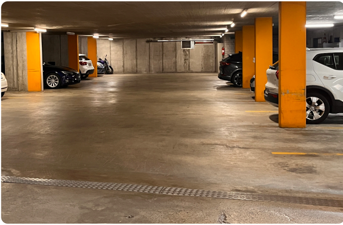
Zustand der Einstellhalle vor der Instandsetzung
