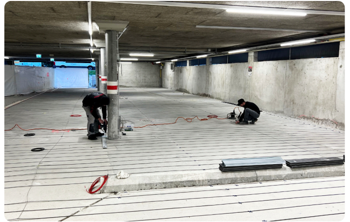
Verlegen der Anodenbänder für den kathodischen Korrosionsschutz
