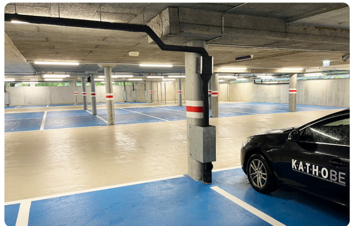
Fertige Einstellhalle nach der Instandsetzung, die KKS-Installation ist nicht mehr sichtbar
