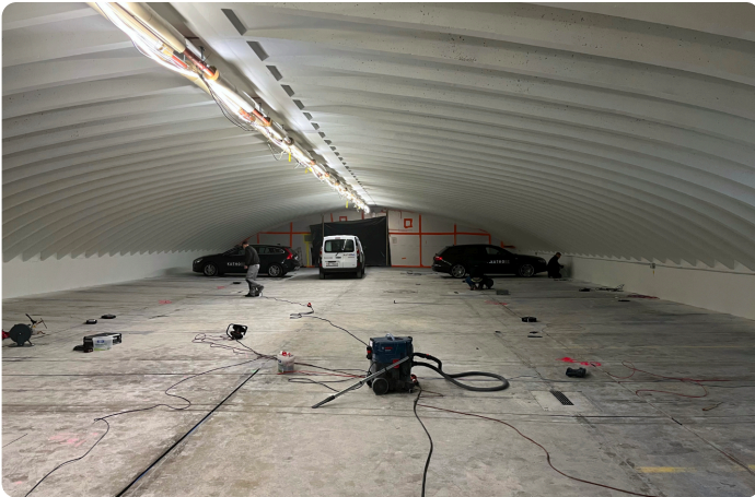
Installation der Bandanoden in den zuvor erstellten Schlitzen
