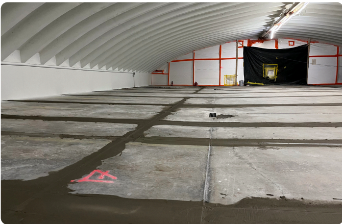
Vergiessen der Schlitze mit Flüssigmörtel
