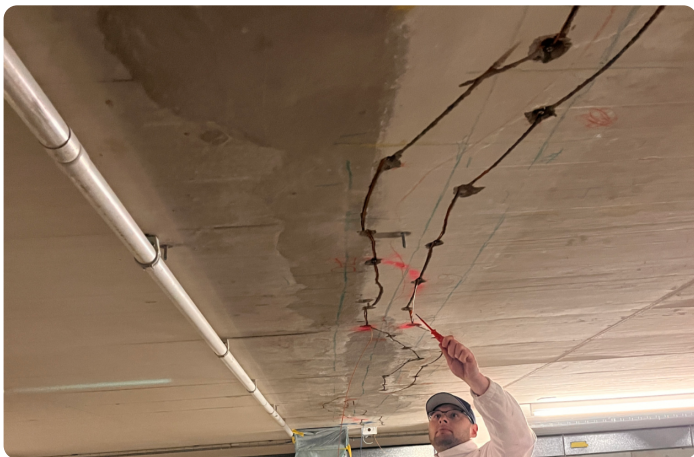
Verdrahten der Stabanoden
