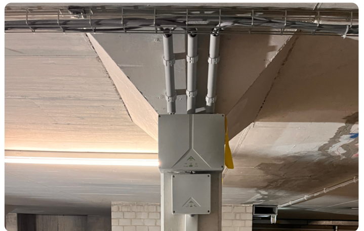
Kabelführung in Lehrrohren und Trasse bis zu Steuerschrank
