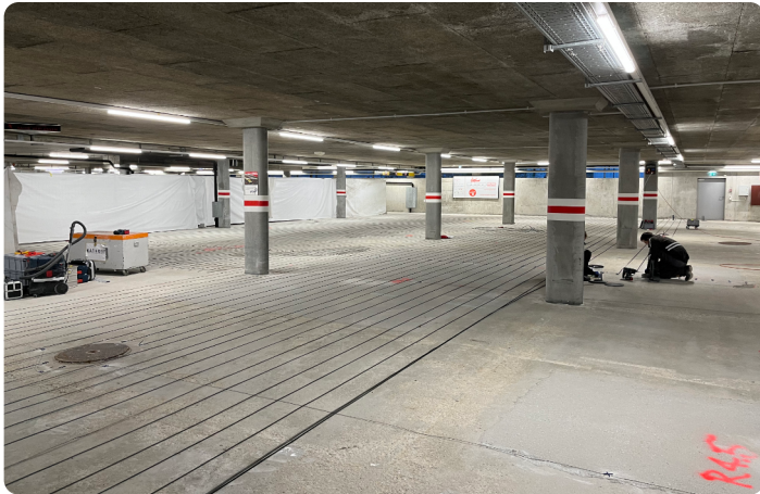
Verlegen der Anodenbänder für den kathodischen Korrosionsschutz
