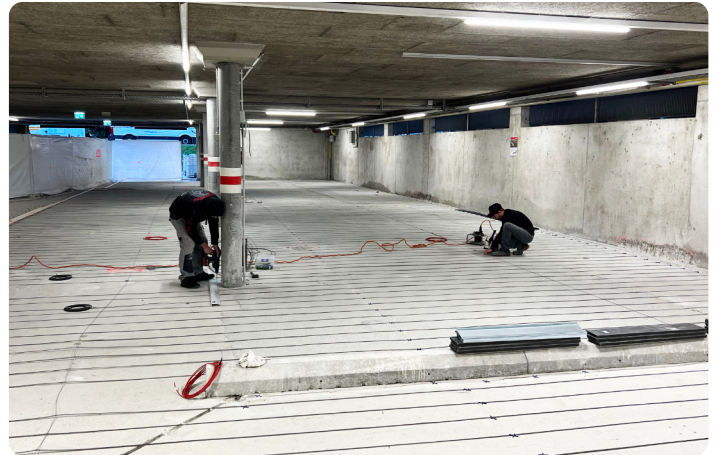
Verlegen der Anodenbänder für den kathodischen Korrosionsschutz
